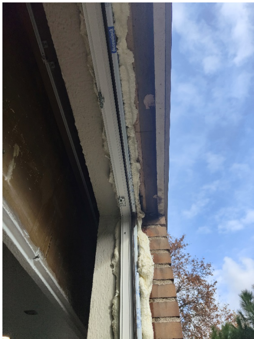
Proceso de sustitución de huecos. Aislamiento perimetral.
