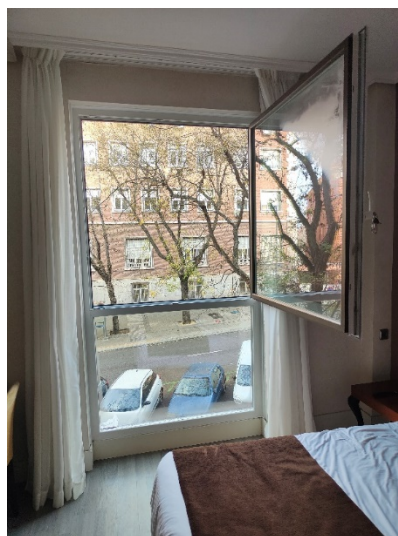
Ventana: Vista interior. Obra finalizada
