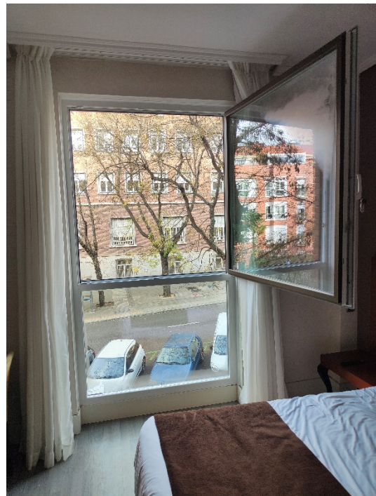
Ventana: Vista interior completa. Apertura abatible abierta. Obra finalizada
