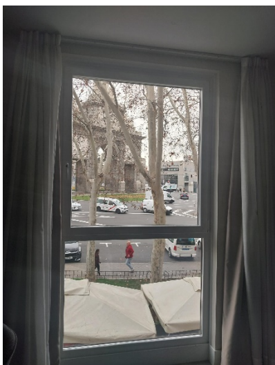
Ventana: Vista exterior durante montaje
