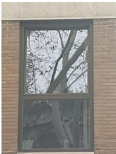
Vista exterior ventana nueva
