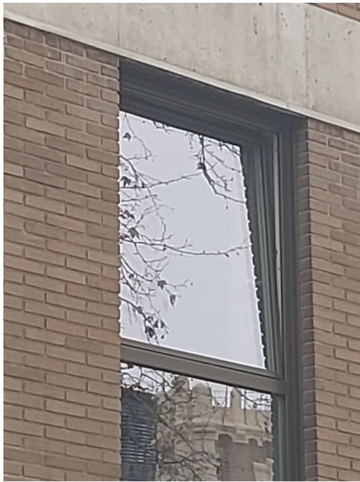
Ventana: Vista exterior oscilobatiente abierto Obra finalizada
