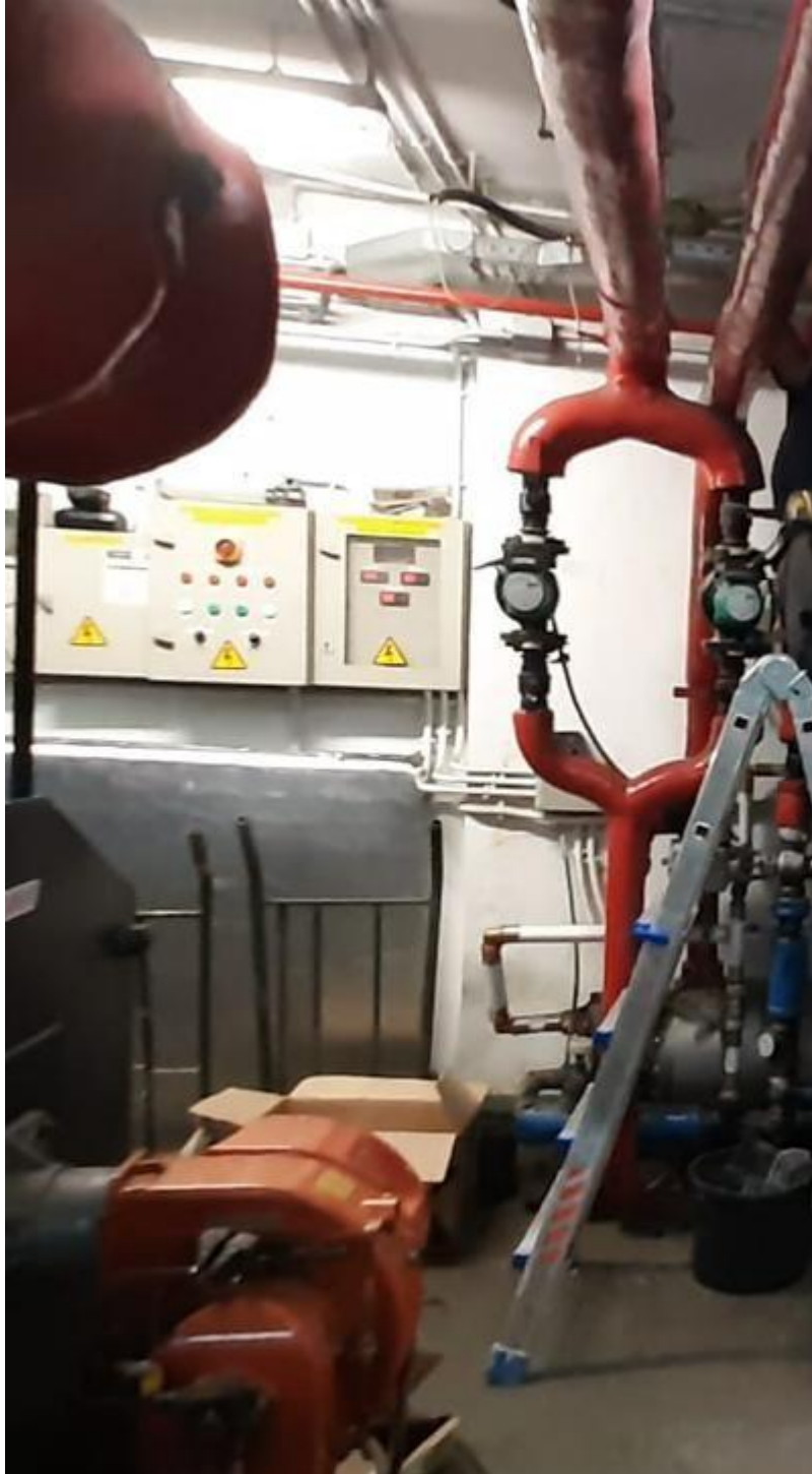
Detalle desmontaje instalación existente
